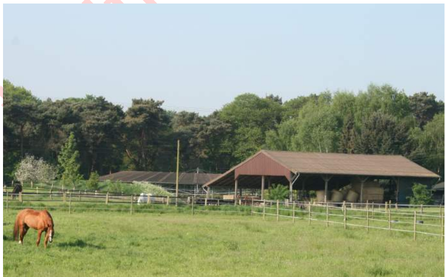
Großzügige Mehrzwecklagerhalle, auch für Stroh bestens geeignet
